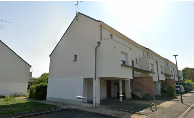
Bâtiments déjà construit sur la parcelle BH 427 (ici îlot A)
